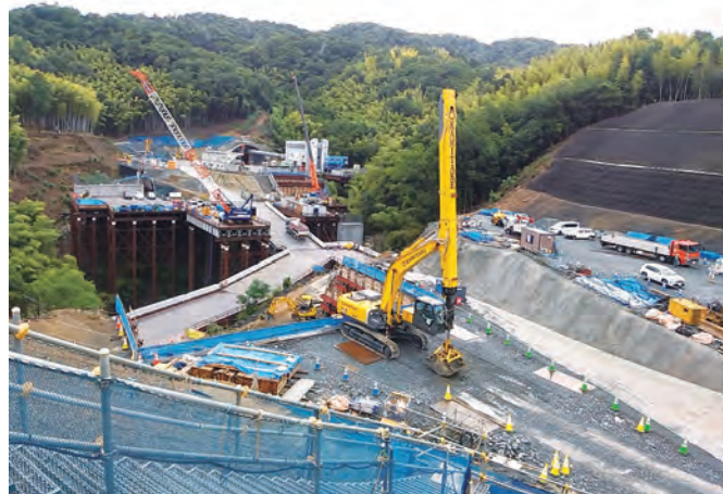
写真-2 梶原トンネル坑口遠景
