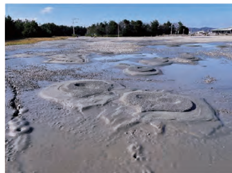
写真-4 液状化による噴砂跡
