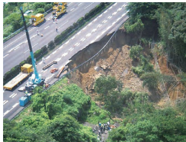
写真-2 被災状況 出典：中日本高速道路（株）
