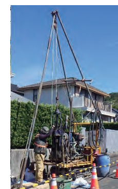
写真-2 ボーリング調査の様子
