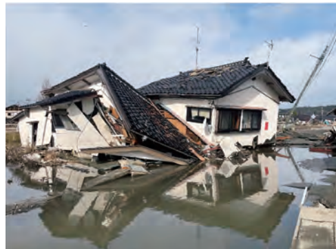
写真-2 強震による家屋の破壊状況
