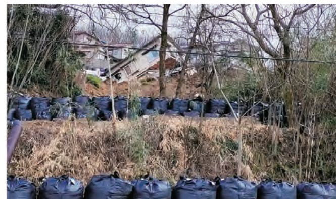
写真-1 金沢市田上新町の造成宅地被害
