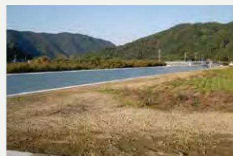
切目川の復旧状況
