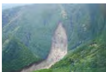
写真-2 平鍋地区の大規模崩壊
