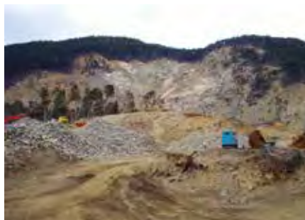
写真-9 和歌山県田辺市熊野地区の斜面崩壊
