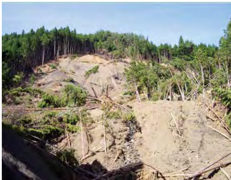
写真-6 奈良県天川村冷水地区の斜面崩壊
