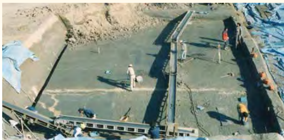
図-1 木津川河床遺跡に現れた液状化現象の痕跡 真っ直ぐのびる砂の帯が砂脈である(以下の写真はすべて寒川撮影)。
