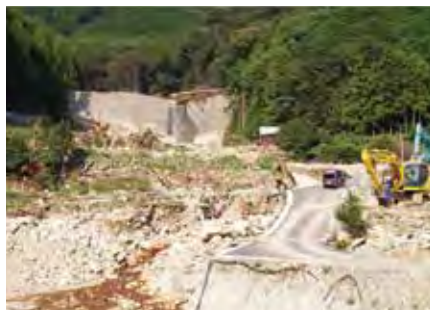
写真-11 和歌山県那智勝浦町の土石流被害
