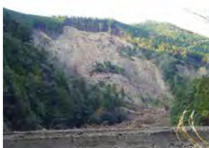
写真-10 和歌山県田辺市三越地区の斜面崩壊
