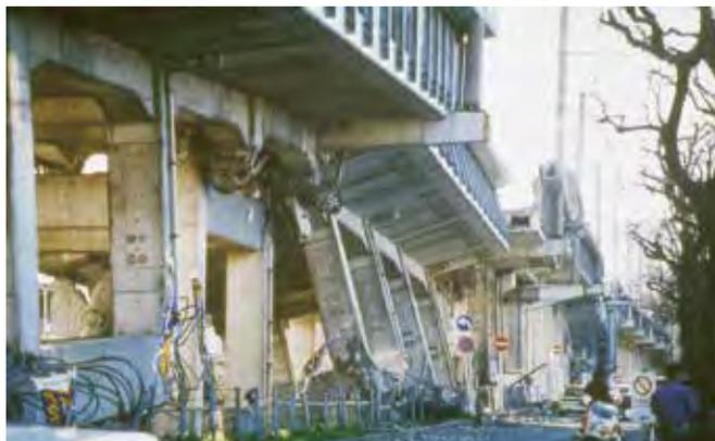
写真-1 山陽新幹線高架橋の被災状況
