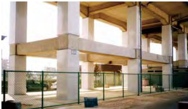
写真-2 高架橋耐震補強（鋼板巻き立て工法）
