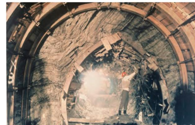
図-3 泥岩中のトンネルの変状例
