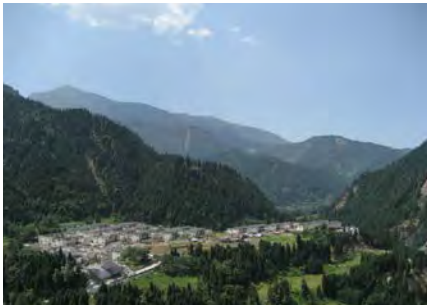
写真10 崩壊堆積物上に建設された全壊に近い量溪鎮リゾート用の建物：彭州市銀廠溝
