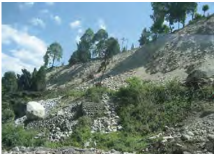
写真3 段丘崖の崩壊：彭州市龍門山鎮
