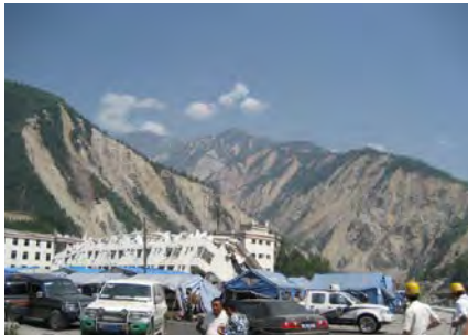
写真13 全壊に近い建物と周囲の山腹崩壊
