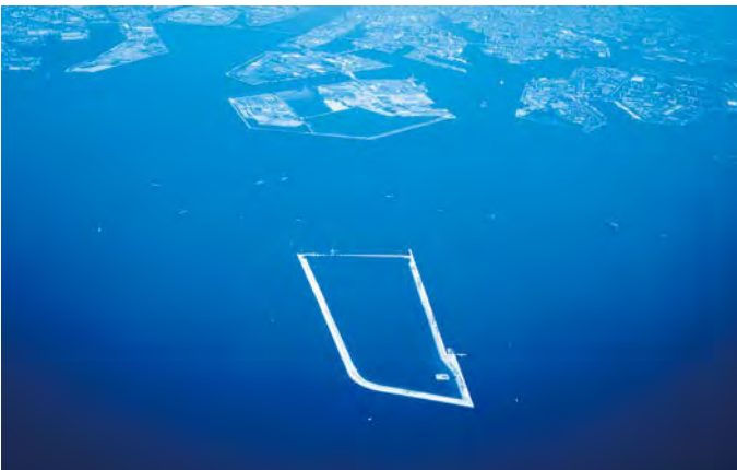
大阪沖埋立処分場(建設中)
