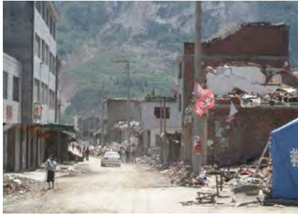
写真12 山地内の平坦面で破壊した建物：北川県擂鼓鎮
