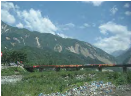
写真2 彭州市龍門山鎮近くの斜面崩壊（橋梁は通行止め）
