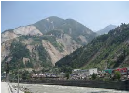
写真14 珉江と山腹の間に建てられた建物被害 北川県映秀鎮
