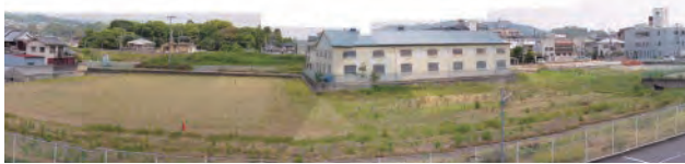
雨水処理施設上に設けられたフットサル競技場
