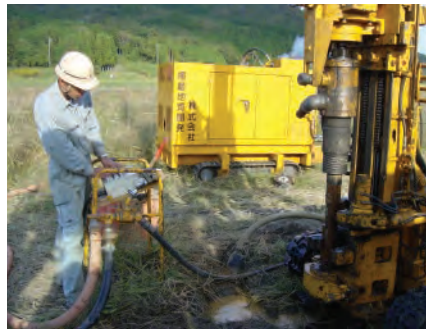
パーカッションワイヤーラインサンプラー工法の水源調査への適用。掘進長110mをワイヤーラインサンプリング工法で実施し、目視により帯水層を確認できました。 播磨地質開発(株)
