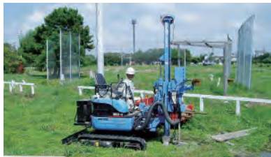
土壌汚染調査で使用したボーリングマシン
