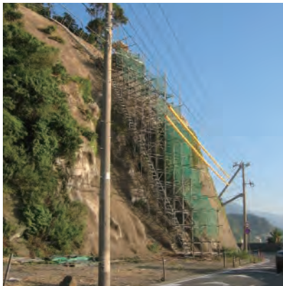
高さ20m超の急斜面上において、国定公園内の切土計画に必要な地盤調査を実施しました。 中央測量設計(株)
