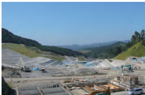
甲賀市神地区では産業廃棄物処分場(写真左)の建設と市道次良九郎線(写真右側)の付替え工事が進行中です。 (株)関西技研
