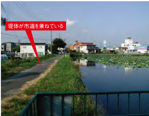
写真2 改修前の堤体
