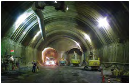
超大断面部施工中(側壁導坑)
