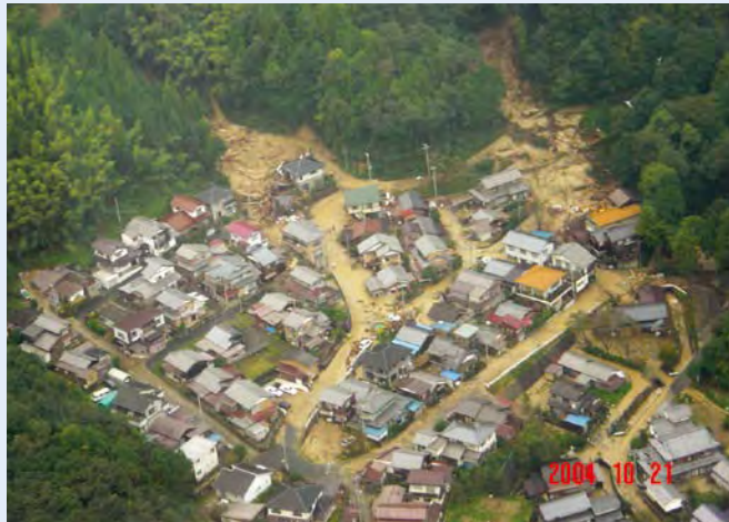
宮津市滝馬地区で土石流が発生(H16.10.21)
