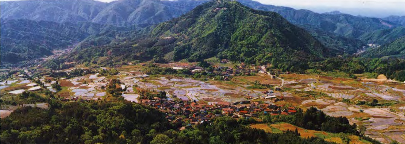
図6 丹土地すべりの全景（兵庫県、1996）
