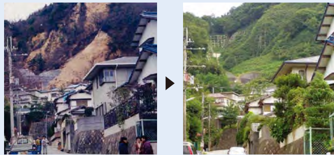
写真-1 六甲山系グリーンベルト整備事業 山腹工事・樹林整備の施工例
