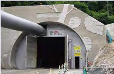
とりがたわトンネル起点側坑口
