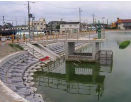
写真4 改修後の堤体
