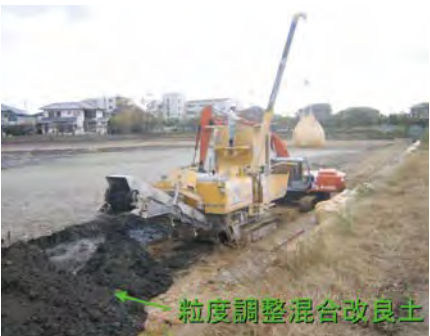
写真3 自走式土質改良機
