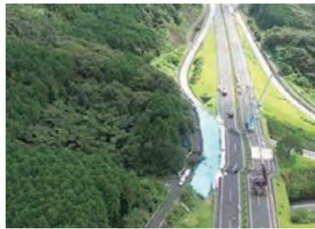
写真-1 武雄ジャンクションで発生した災害
