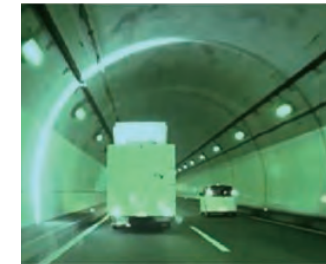
写真-2 カメラ搭載車検査状況例
