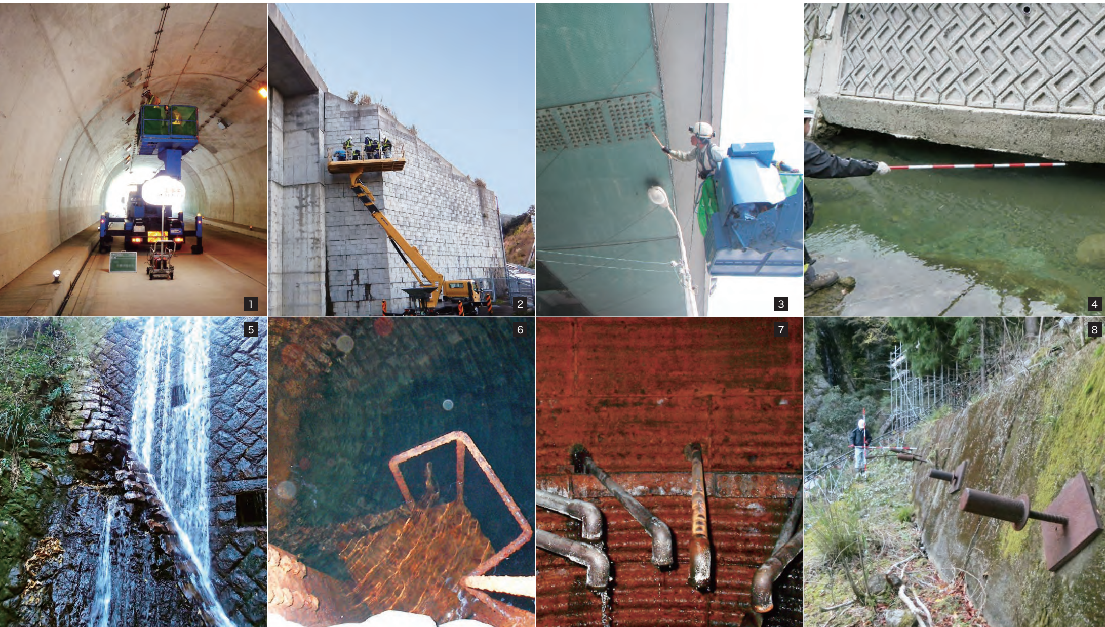
1 トンネル点検 2 盛土（補強土）点検 3 橋梁点検 4 護岸工点検 5 老朽化した堰堤 6 老朽化した集水井工 8 老朽化したグラウンドアンカー工
