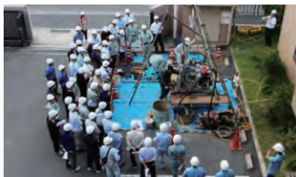
ボーリング現場見学の様子
