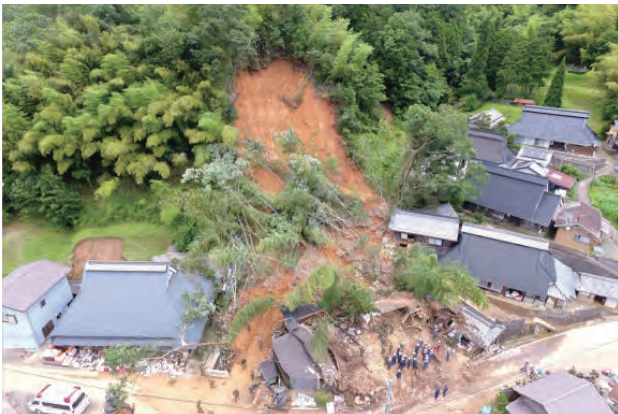
斜面崩壊現場の写真。裏山が崩壊して土砂が流入、家屋が倒壊している。 (京都府提供資料)
