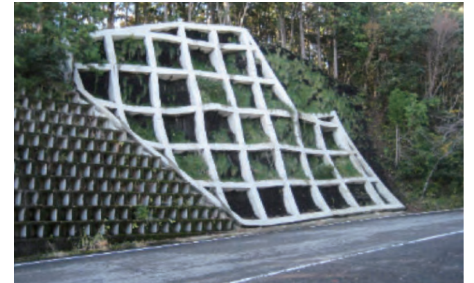
写真-3 法枠工の例
