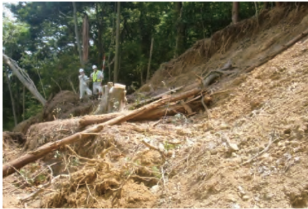
斜面崩壊現場における被害状況調査（滋賀県長浜市）
