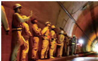
トンネルの変状調査を学ぶ(地盤研修会)
