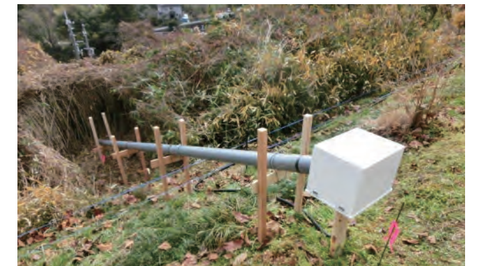
写真-3 盛土のモニタリング 写真提供：(株) オサシ・テクノス
