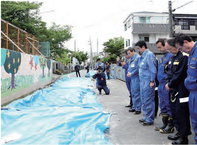
写真-2 ブロック塀の倒壊
