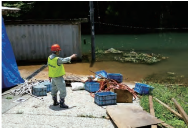
河道閉塞現場における被害状況調査（兵庫県加東市）
