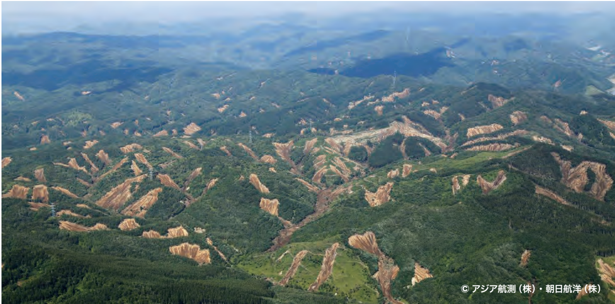
写真-1 厚真町で発生した斜面崩壊
