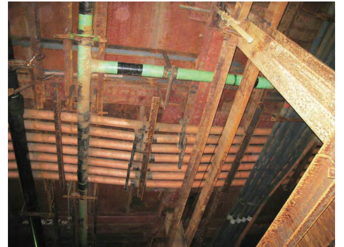
地下鉄工事で地表から地下へ移設した配管
