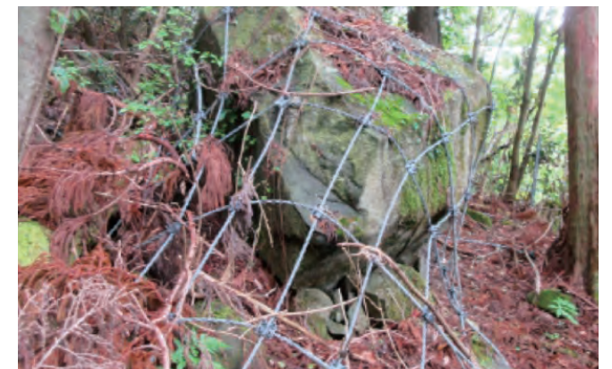
写真-4 ロープネット工の例
