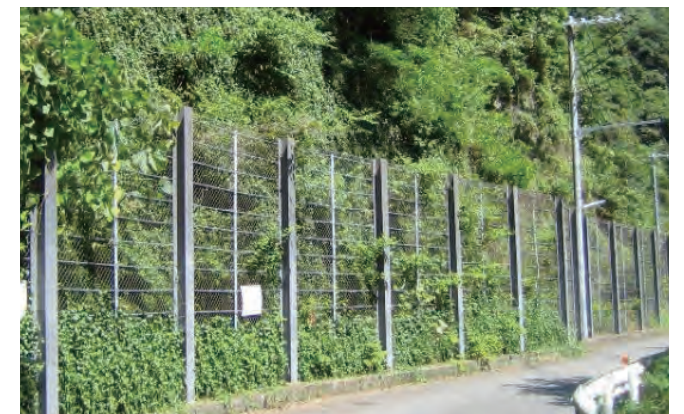
写真-5 落石防護柵工の例
