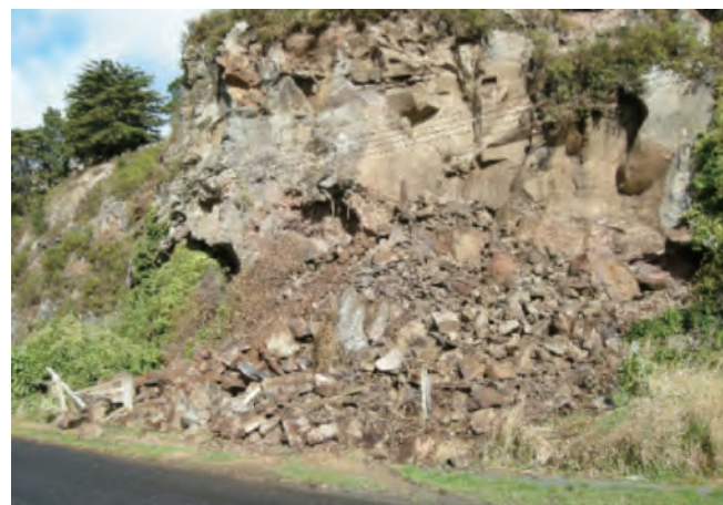
写真-1 崖崩れの例
