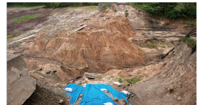
写真-1 東日本大震災で決壊した藤沼湖の堤防（この決壊により、死者7名・行方不明者1名の犠牲ができました。）
