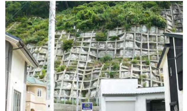
写真-2 法枠工の写真
