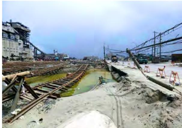
写真-1 液状化による地面の沈下
