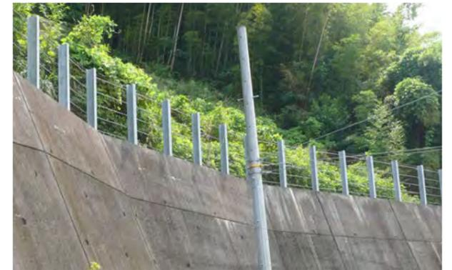
写真-3 落石防護柵工の写真
