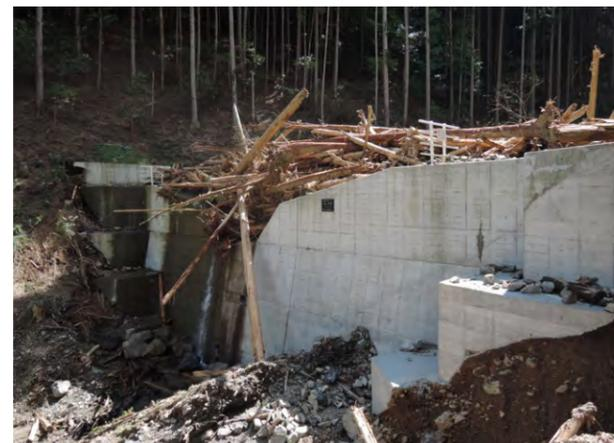
既設の治山ダムによる土石・流木の捕捉状況
