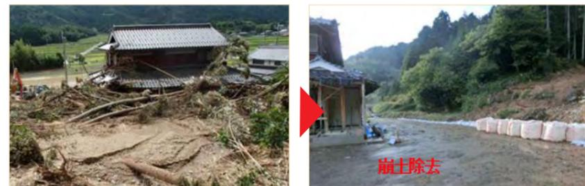
写真-4 人家裏の崩壊土砂除去、大型土のう応急対策
