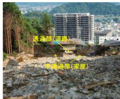
写真-3 谷出口付近の土砂の堆積状況
