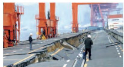
写真-2 液状化による護岸構造物の被害(神戸港)
