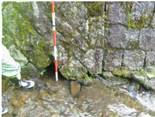
写真-3 護岸石材の抜け落ち
