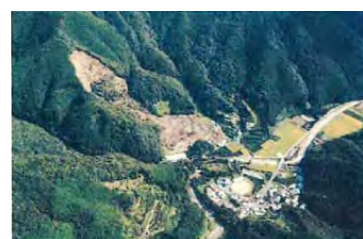
写真-1 田辺市伏菟野地区大規模崩壊
