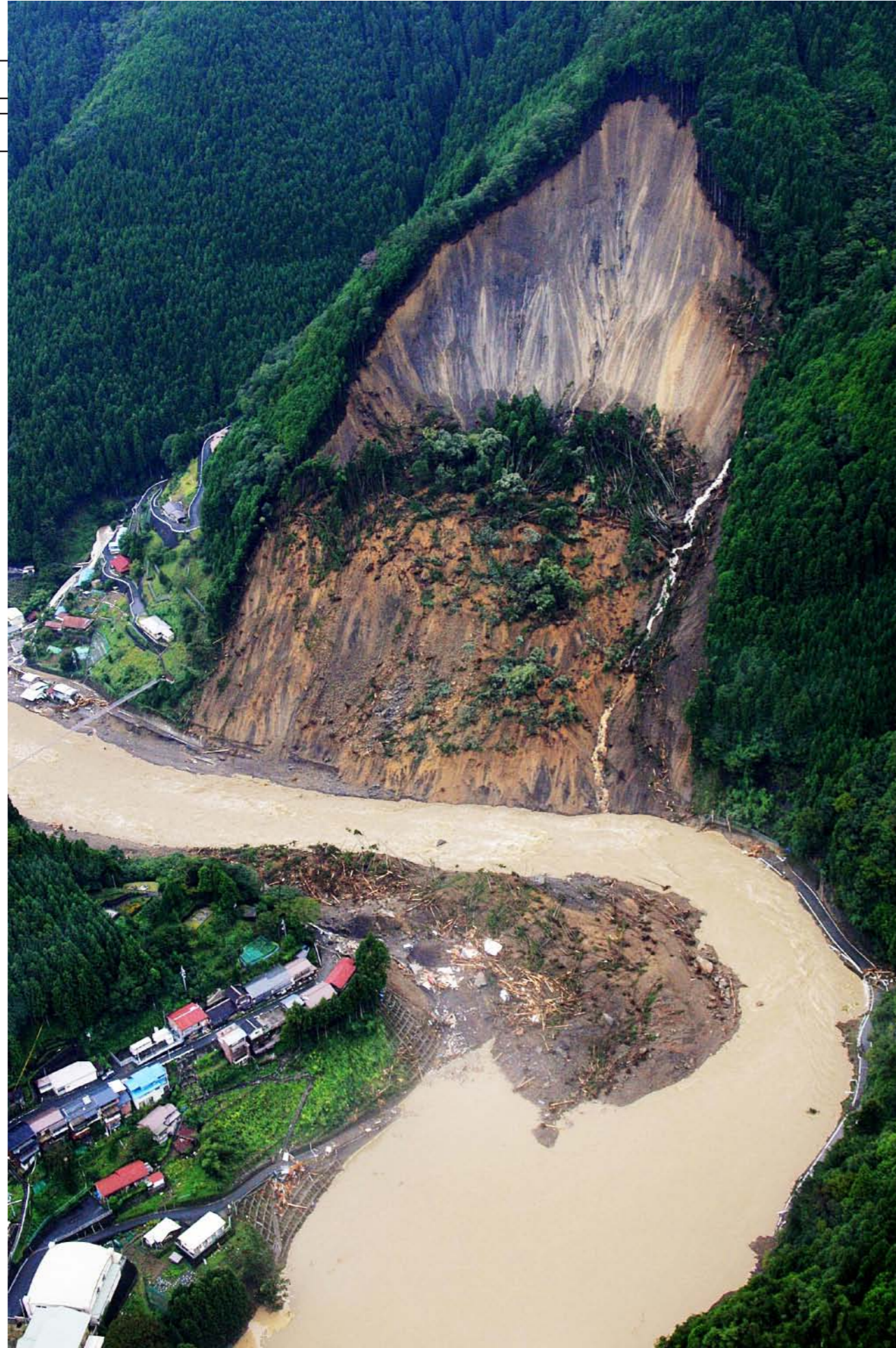
五條市大塔町宇井で2011年9月4日午後3時10分、本社ヘリから三村政司撮影奥の斜面が崩れて天ノ川をせき止め、あふれた水が中央にあった民家数棟を押し流した(奈良県)
