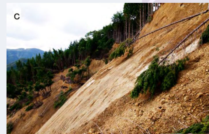
図-4 崩壊地に露出したせん断面。鏡肌を有し、湾曲・分岐・併合を繰り返す。 a:赤谷の崩壊の向かって右上部。 b:aの四角内。岩石は混在岩。 c:北股の崩壊最上部。
