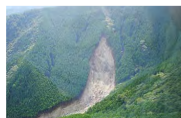
写真-2 平鍋地区の大規模崩壊
