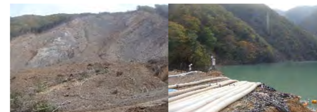
写真-1 台風12号による赤谷の深層崩壊と緊急対策
