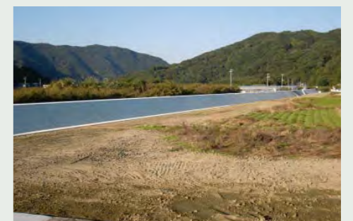
切目川の復旧状況
